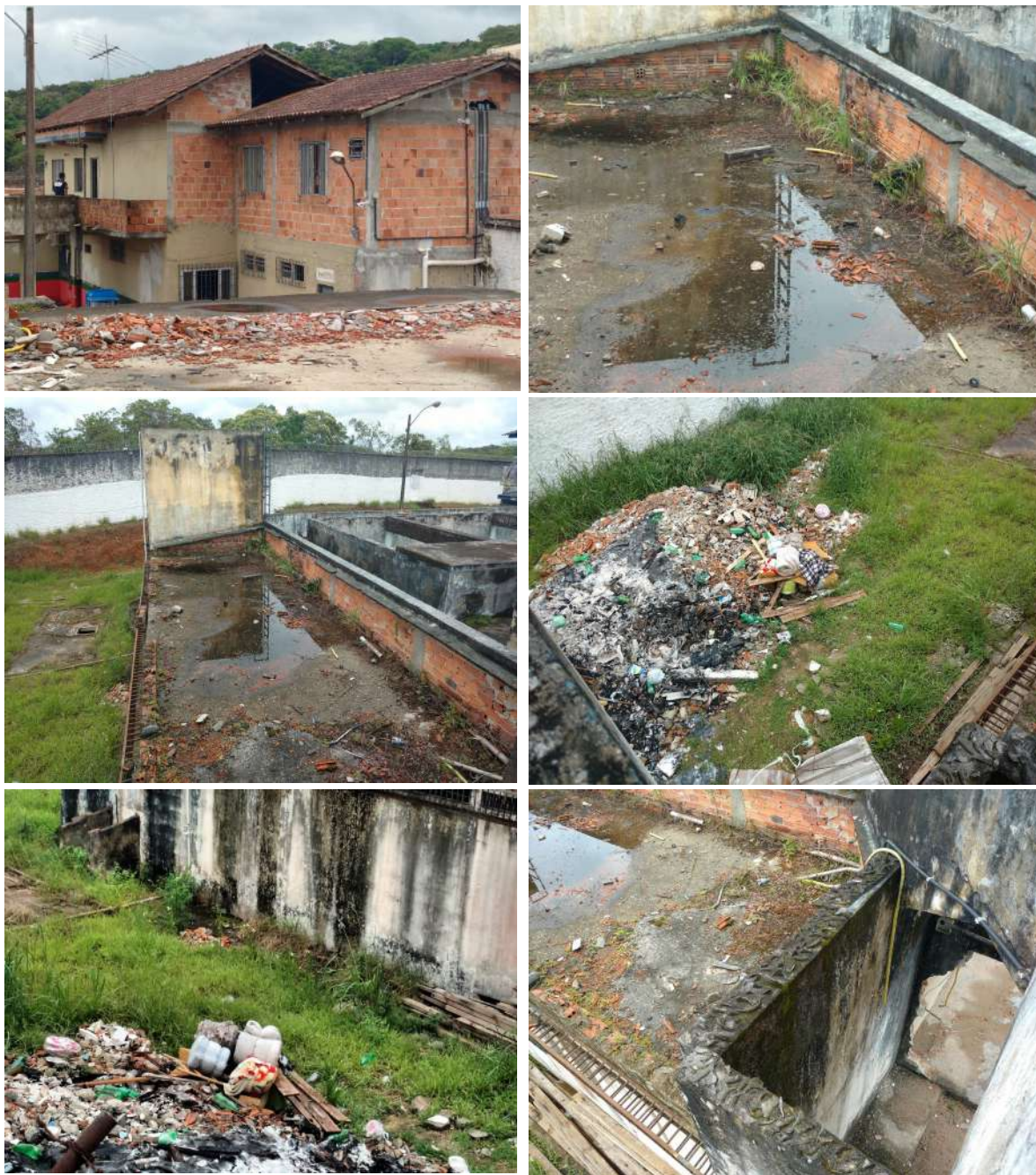
Água acumulada, lixo, infiltração próximo ao Pavilhão IV.
