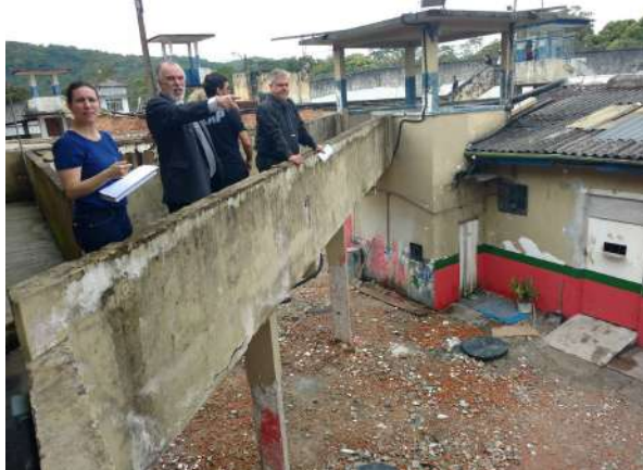
Vista da entrada área interna do Pavilhão I. Entulhos, áreas danificadas e demolidas.
